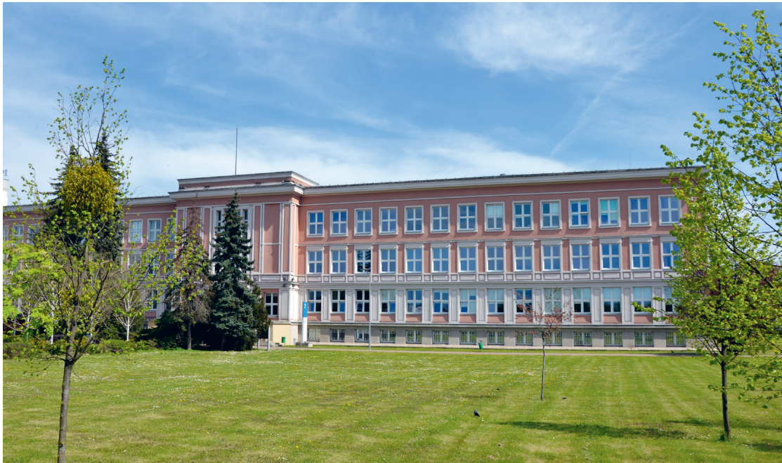
Budynek budownictwa (A2)
