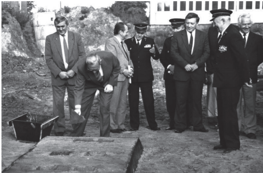
Wmurowanie kamienia węgielnego pod halę laboratoryjną Środowiskowego Laboratorium Budownictwa i Komunikacji. Od lewej: inż. J. Woźniak, rektor PP prof. A. Ryżyński – wmurowuje akt erekcyjny, C. Krzywosz – dyrektor Generalnej Dyrekcji Dróg Publicznych, A. Głowacki – wiceminister komunikacji, dyrektor Z. Pajdak – Dyrekcja Okręgowa Kolei Państwowych, R. Stemplowski – wojewoda poznański, dyrektor J. Pieprzyci – Przedsiębiorstwo Robót Kolejowych nr 10, prof. C. Królikowski – wiceminister edukacji
