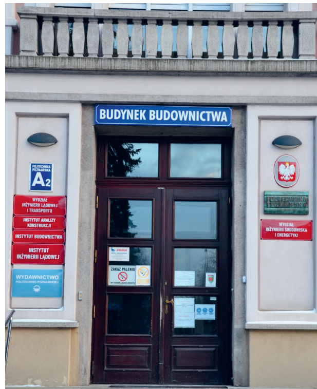
Drzwi frontowe budynku budownictwa (A2)
