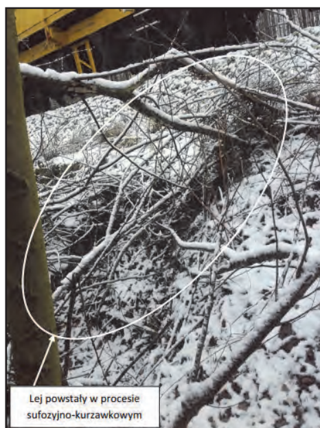
Rys. 5. Lej powstały w procesie sufozyjno-kurzawkowym w skarpie nasypu kolejowego
