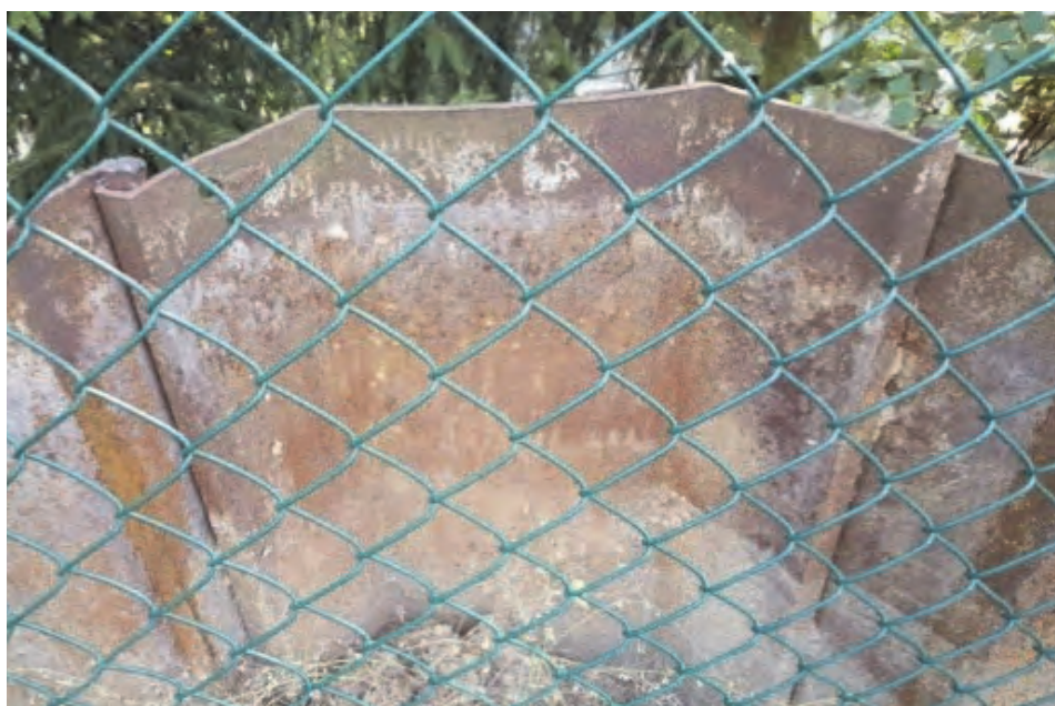
Rys. 7. Wyprostowanie ścianki Larsena
