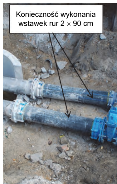
Rys. 6. Po awarii wystąpiła konieczność przedłużenie rur o ponad 90 cm
