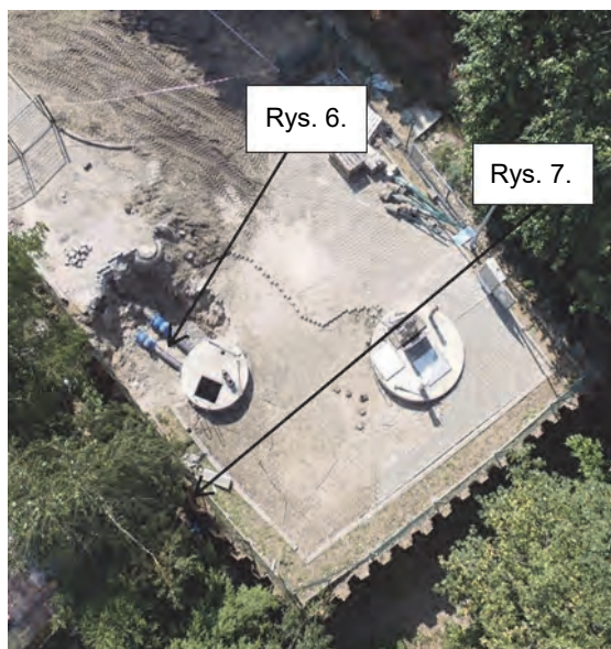
Rys. 5. Widok przepompowni ścieków Przedsiębiorstwa Komunalnego
