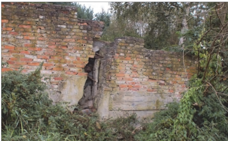
Rys. 1. Mur ogrodzeniowy klasztoru oo. Franciszkanów
