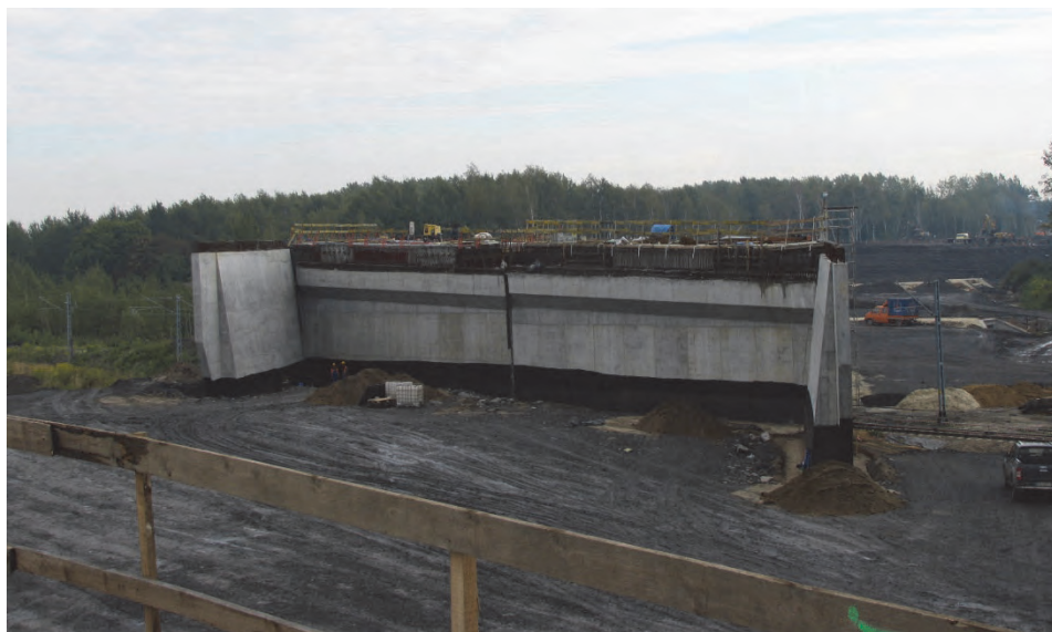
Rys. 1. Przyczółek podczas budowy
