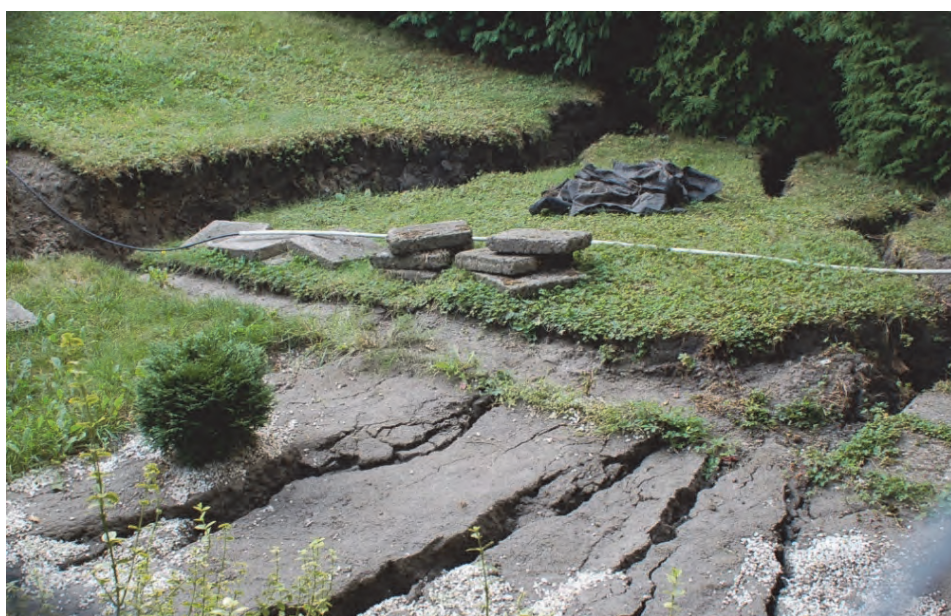
Rys. 9. Przykład zniszczeń na terenie ogrodów działkowych
