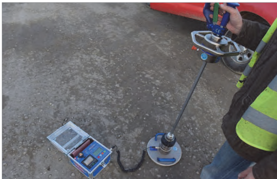
Rys. 3. Pomiary nośności dynamiczną płytą sztywną – aparatura badawcza
