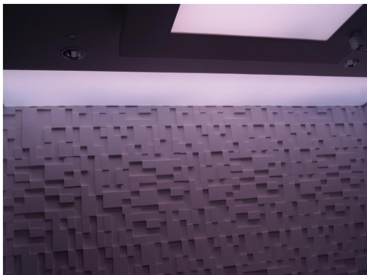
Il. 1.7. Modułowy relief ścienny z dynamicznym oświetleniem, Centrum Zastosowań Światła w Pile, fot. H. Michalak
