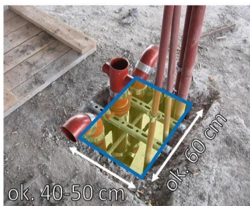
Rys. 18. Podłączenie dwóch sąsiadujących łazienek (umywalka, WC i brodzik natrysku) do jednego pionu – przykład z obiektu w trakcie budowy
