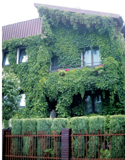
Ilustracja 2. Budynek w pełni porośnięty zielenią, po podcięciu odrostów przy otworach okiennych (2007 – 14 lat od posadzenia roślin)
