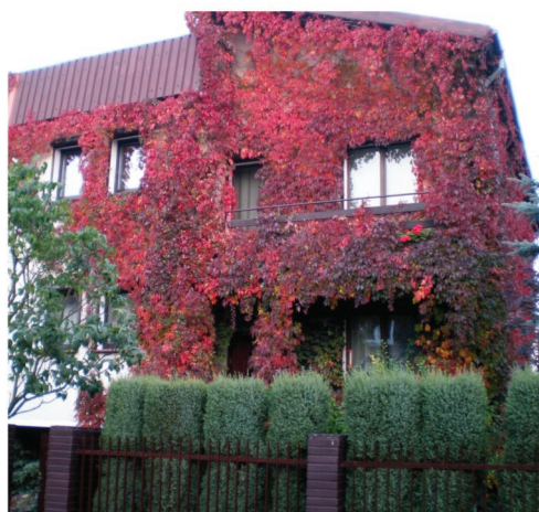
Ilustracja 3. Budynek w pełni porośnięty zielonią (jesień 2008 – 15 lat od posadzenia roślin)
