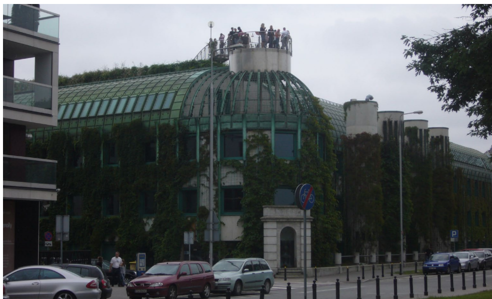
Ilustracja 7. Dach Biblioteki Uniwersytetu Warszawskiego, ul. Dobra 56/66, Warszawa (lipiec 2018) Źródło: fot. A. Kasińska-Andurszkiewicz.
