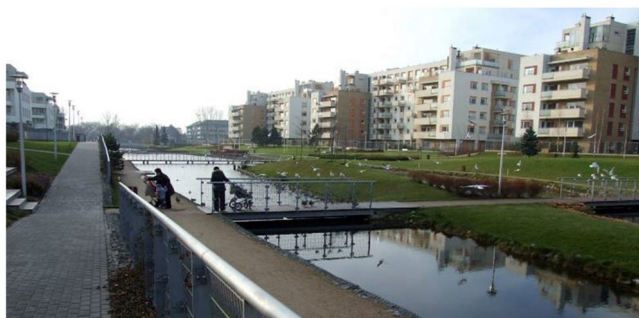
Ilustracja 13. Wielokomorowy zbiornik retencyjny na osiedlu Marina Mokotów w Warszawie, stanowiący główną atrakcję osiedla i miejsce rekreacji mieszkańców. Proj. APA Kuryłowicz & Associates
