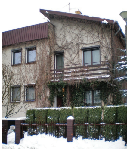
Ilustracja 4. Budynek w pełni porośnięty zielonią (zima 2010 – 17 lat od posadzenia roślin)
